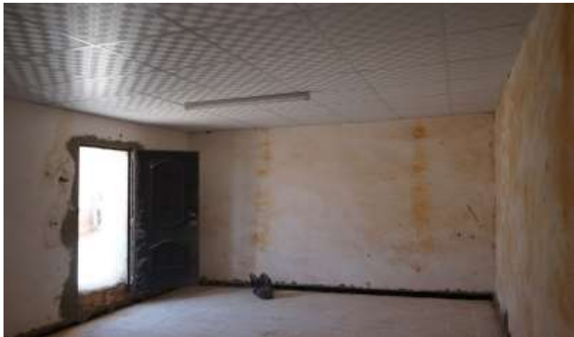
Mejoras en las instalaciones
