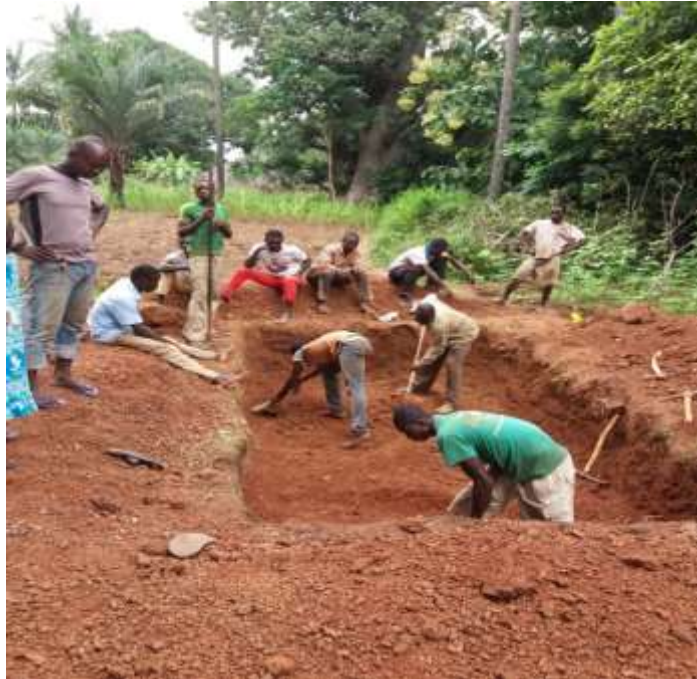
Distintas fases de la construcción de las letrinas
