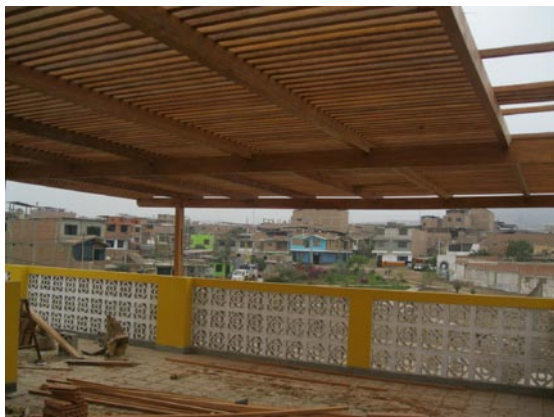
Construcción centro formación
