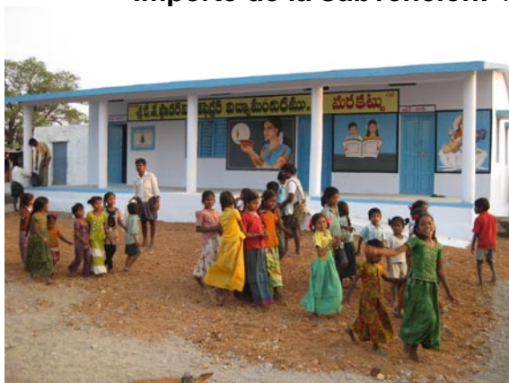
Escuela construida en Marakattu
