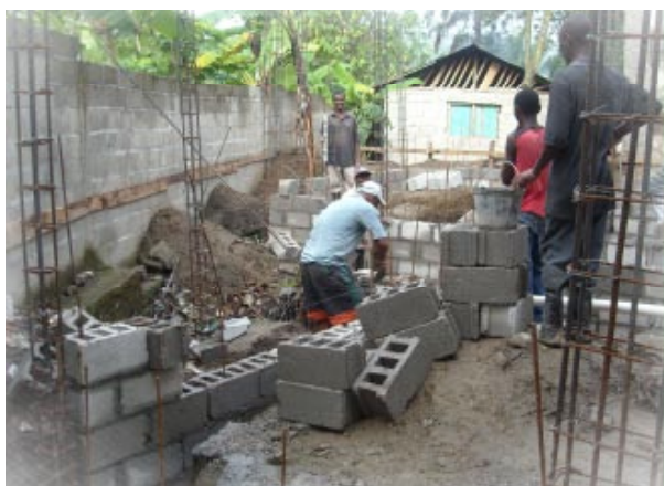
Obras para ampliación dispensario
